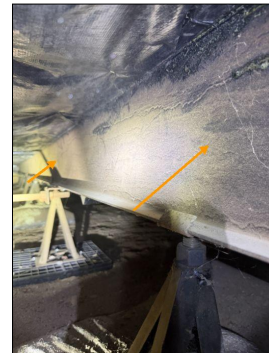
Viga de acero mostrada como referencia
