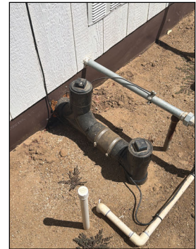
Registro de limpieza de desagüe sin defectos
