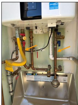
Líneas calientes/frías mostradas como referencia Bandeja de drenaje del calentador sin tanque: no se observaron defectos
