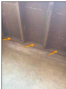
Placa inferior de pared sin defectos visibles
